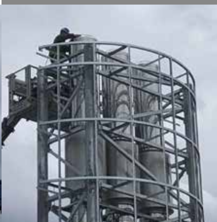
Traliccio di sostegno, Ø 50 700 mm. lunghezza totale 80 m 3 silenzianti speciali.
