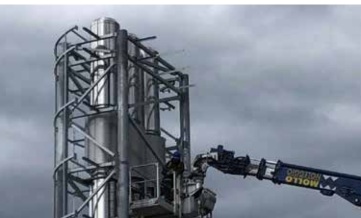
Traliccio di sostegno, Ø 50 700 mm. lunghezza totale 80 m 3 silenzianti speciali.
