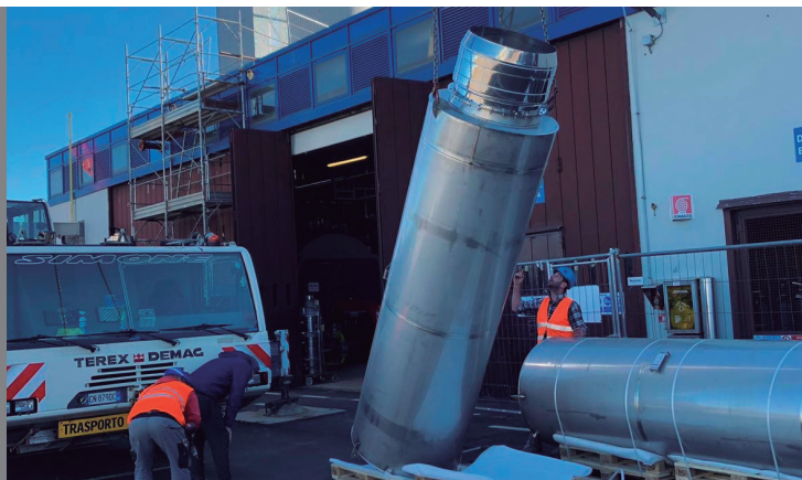
Traliccio di sostegno, Lunghezza totale 80 m. 2 camini modulari e canali da fumo DW KL 700 mm
