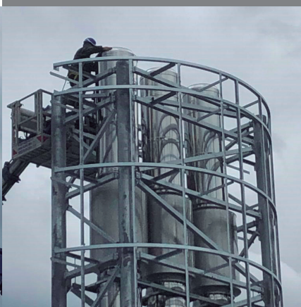
Traliccio di sostegno, Ø 50 700 mm. lunghezza totale 80 m 3 silenziatori speciali.
