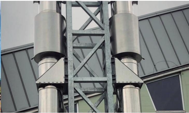
Traliccio di sostegno, 2 silenziatori HP. Lunghezza totale 30 m. 2 camini modulari e canali da fumo DW ECO Ø 450 mm.
