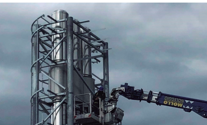
Traliccio di sostegno, Ø 50 700 mm. lunghezza totale 80 m 3 silenziatori speciali.
