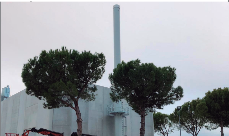
Traliccio di sostegno, 2 silenziatori HP. Lunghezza totale 30 m. 2 camini modulari e canali da fumo DW ECO Ø 450 mm.
